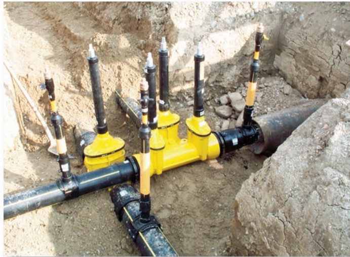
Gasleitungsschieberkreuz
