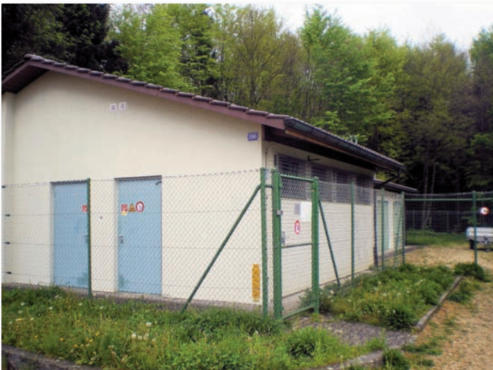
Druckreduzier- und Messstation
