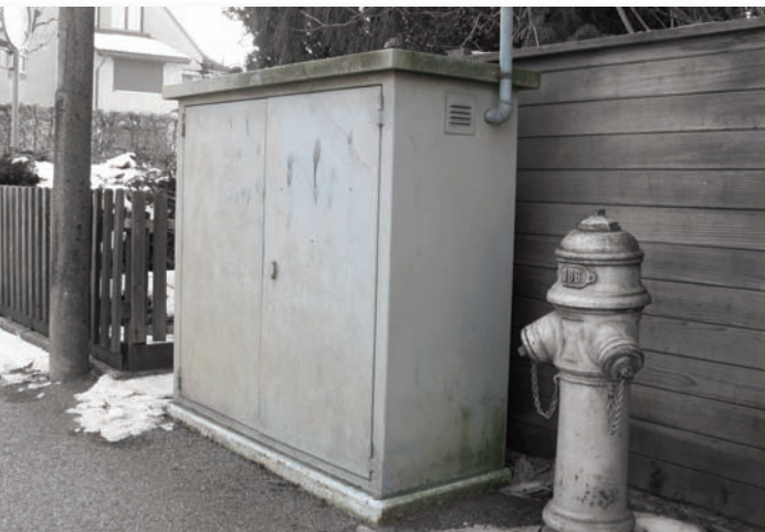
Druckreduzier- und Verteilnkabine (Niederdruck)
