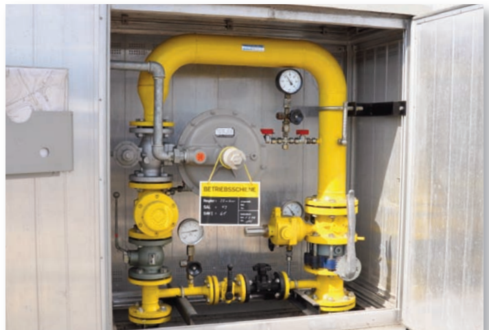
Druckreduzierstation Mitteldruck zu Niederdruck
