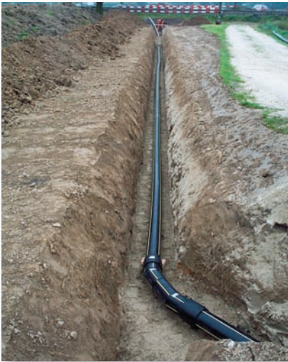
Verlegte ND-Erdgasleitung
