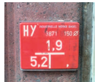
Hinweisschild Unterflurhydrant (gibt Position des Hydranten an)
