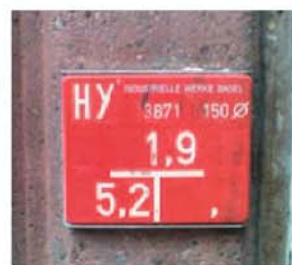
Hinweisschild Unterflurhydrant (gibt Position des Hydranten an)
