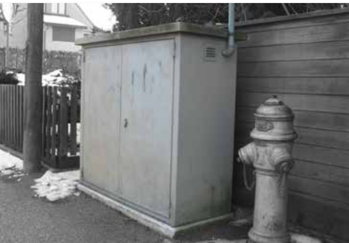
Druckreduzier- und Verteilkabine (Niederdruck)
