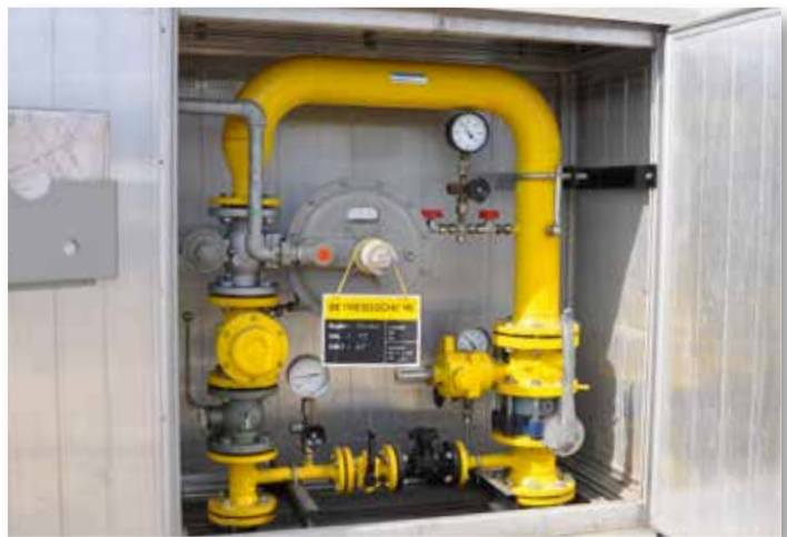
Druckreduzierstation Mitteldruck zu Niederdruck
