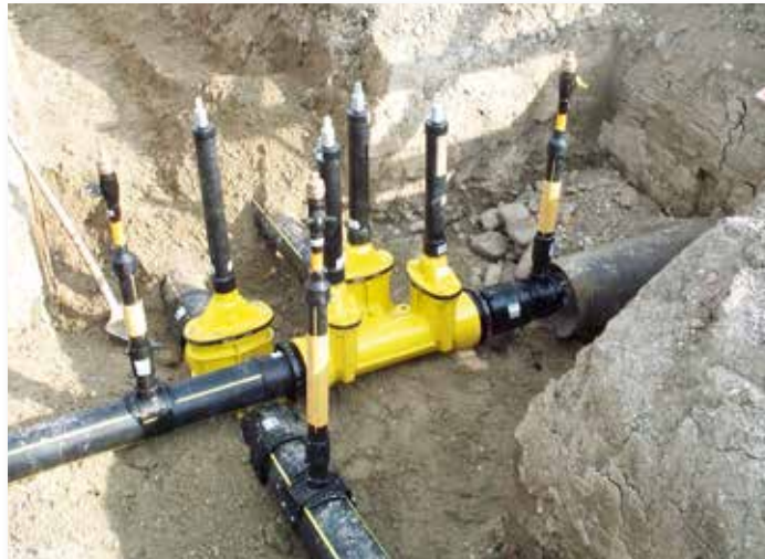
Gasleitungsschieberkreuz
