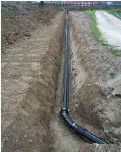
Verlegte ND-Erdgasleitung
